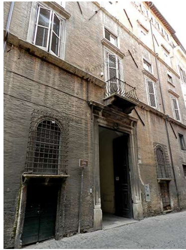
Arma Planca e palazzo Planca Incoronati.
